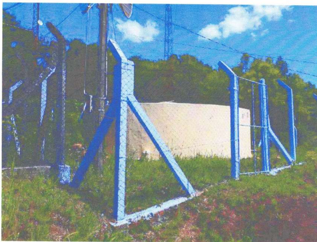
Figura 19 - Reservatório 2, desativado. Fonte: PMSB 1ª Revisão, 2018.
